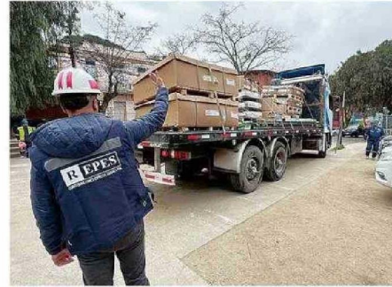
LAS FAENAS DE INSTALACIÓN SERÁN PROGRESIVAS.
