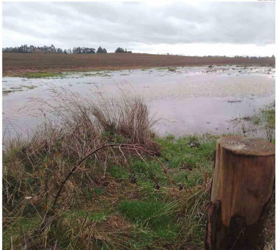
EL VERTEDERO POR ESTOS DÍAS ESTÁ COLAPSADO Y LOS VECINOS ACUSAN DE QUE HAY ESCURRIMIENTO DE LÍQUIDOS QUE AFECTAN UN PREDIO VECINO.
