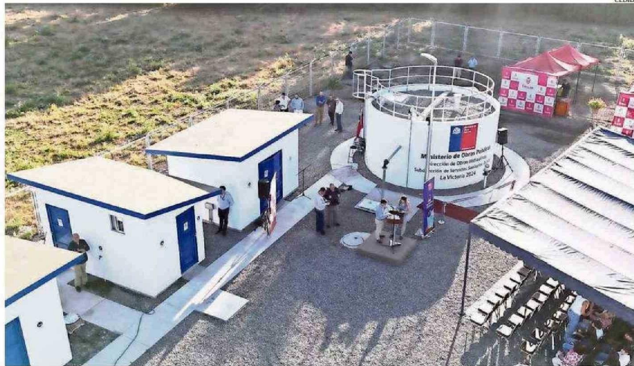
126 APR QUE NO CUENTAN CON UN SISTEMA DE RESPALDO ELÉCTRICO, ASEGURÓ EL GOBERNADOR CRISÓSTOMO.
