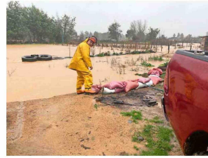
Desagüe y habilitación en la comuna de Santa Juana.
