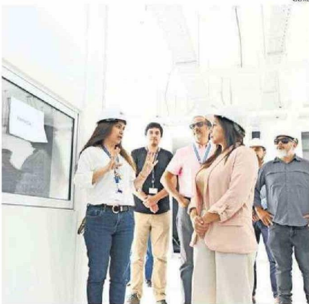
AUTORIDAD VISITÓ OBRAS DEL PRIMER CENTRO DE SALUD AMBIENTAL.
