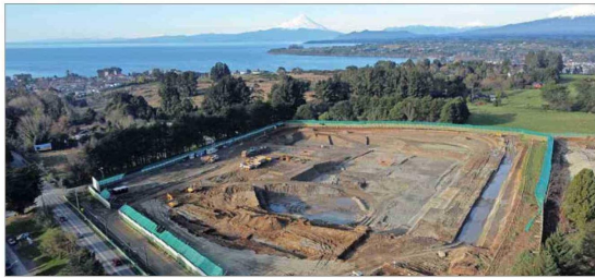
El Hospital de Puerto Varas es una de las iniciativas en que el CMN ha tardado en pronunciarse. El recinto tendrá 190 camas en una extensión que supera los 60 mil m 2 .
