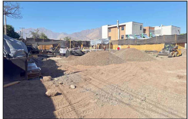
Casi un 20% de avance presentan obras del SAR del Cesfam Segismundo Iturra.
