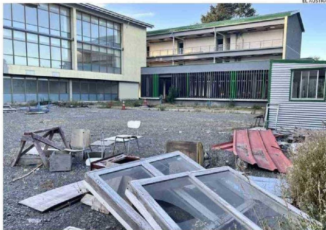
SE ESPERA QUE LAS OBRAS SEAN RETOMADAS A FIN DE AÑO, PARA TENERLAS LISTAS EN 2026.
