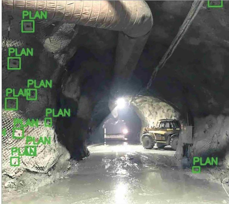
TwinViz detecta fallas específicas en pernos y planchuelas, como cortes, mal posicionamiento o daños.
