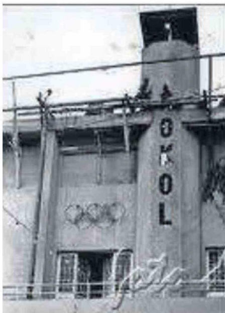
FOTOS HISTÓRICAS, ÚNICAS DE SU CONSTRUCCIÓN.
