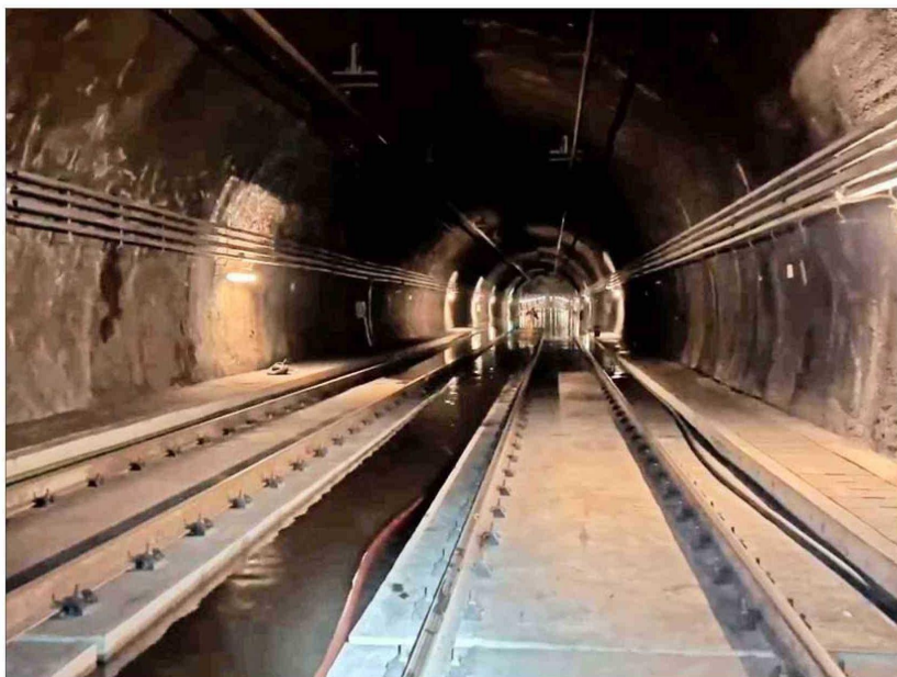
CIERRE. — Durante cuatro días se prolongaron los problemas en estaciones que estuvieron cerradas. La más afectada fue la estación Bío Bío, en San Miguel.
