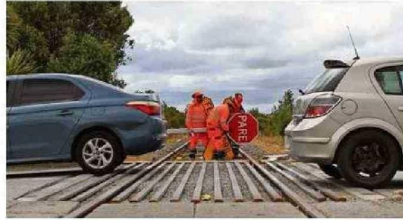
OPERARIOS DE EMPRESAS CONTRATISTAS DE EFE, REALIZAN EL MEJORAMIENTO DE LOS CRUCES FERROVIARIOS.
