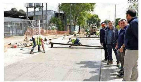
SERVIU INSPECCIONÓ TRABAJOS DE OAVIMENTACIÓN EN 5 DE ABRIL.
