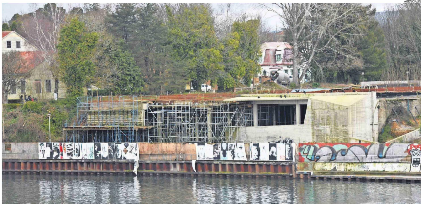
EN 2019 COMENZARON LAS OBRAS PARA LA RESTAURACIÓN Y AMPLIACIÓN DEL MUSEO DE ARTE CONTEMPORÁNEO DE LA UNIVERSIDAD AUSTRAL DE CHILE, EN LA CAPITAL DE LOS RÍOS.
