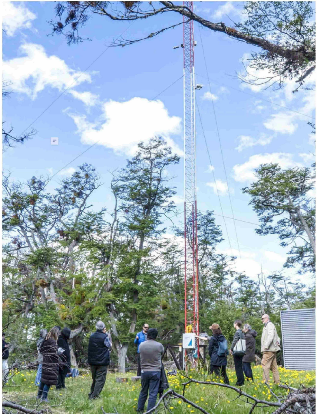
► La torre Eddy Covariance opera en el Parque Etnobotánico Omora, del Centro Internacional Cabo de Hornos, en Magallanes.
