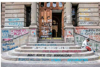
ALAMEDA. Locales comerciales, viviendas, edificios, bibliotecas... pocos muros se salvaron de los rayados.
