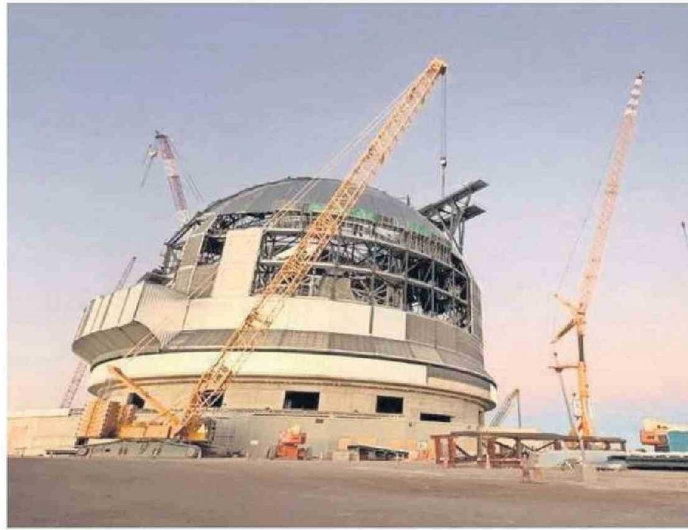
La cúpula que albergará al Extremely Large Telescope en 2028 está en fase de construcción.
