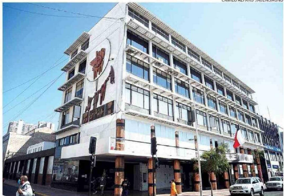
FRONTIS DEL EDIFICIO EN DONDE OPERA LA DELEGACIÓN PRESIDENCIAL.
