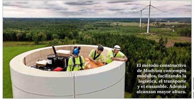
El método constructivo de Modvion contempla módulos, facilitando la logística, el transporte y el ensamble. Además alcanzan mayor altura.
