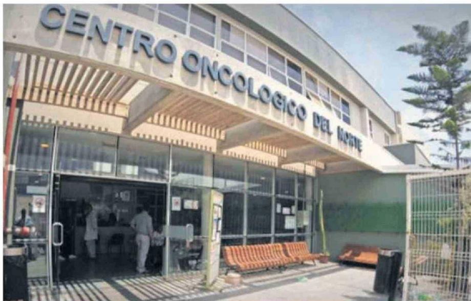
SE HARÁ CAMBIO DE PUERTAS DE TIPO ANTIVANDÁLICAS Y MEJORAMIENTO DEL SISTEMA DE CÁMARAS DE TELEVISIONAMIENTO.
