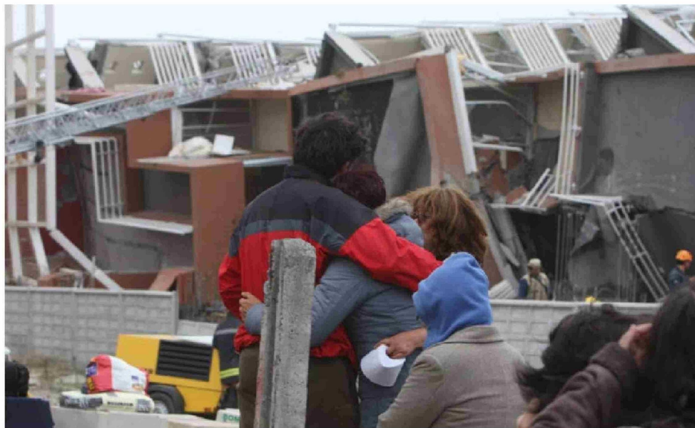
► El desplome del edificio Alto Río en Concepción, una de las imágenes más simbólicas de la tragedia.
