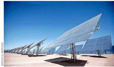
Cerro Dominador, central eléctrica de 210 MW de potencia, combina tecnologías solares fotovoltaicas y termosolares.
