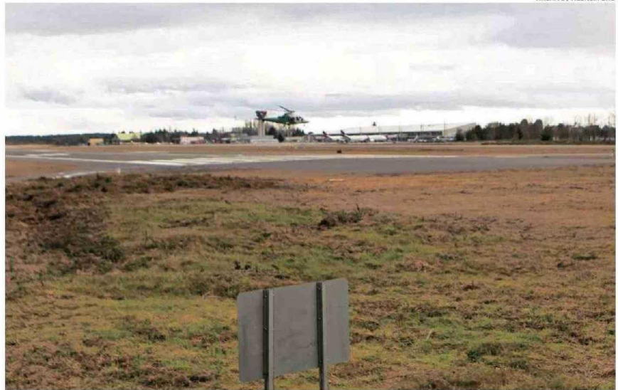
LA DIRECCIÓN NACIONAL DE AEROPUERTOS INFORMÓ QUE LAS OBRAS DE LA NUEVA PISTA DE EL TEPUAL, COMENZARÍAN EN EL AÑO 2027.
