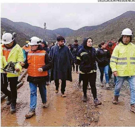
FISCALIZAN OBRAS DE MITIGACIÓN EN MINERA LAS CENIZAS.
