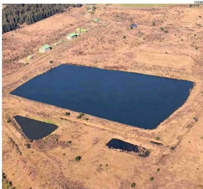
EN LA IMAGEN SE OBSERVA LO ÚNICO QUE QUEDÓ DEL FALLIDO RELLENO: UN ENORME HOYO LLENO DE AGUA.
