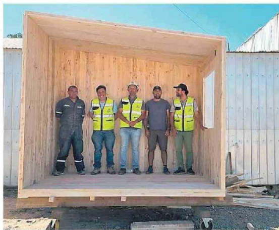
El proyecto "Panel CLT-R" desarrolla viviendas industrializadas con paneles de madera contra laminada reforzada.
