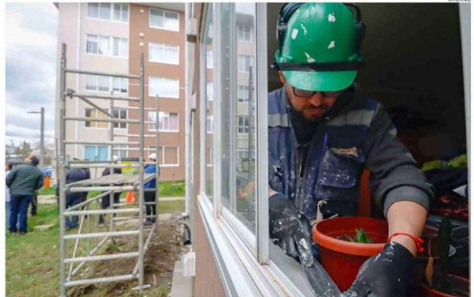
EN SEPTIEMBRE PASADO, LA CONSTRUCTORA INGEVEC REALIZÓ TRABAJOS PARA REPARAR DAÑOS POR HUMEDAD Y POR LA APARICIÓN DE HONGOS.
