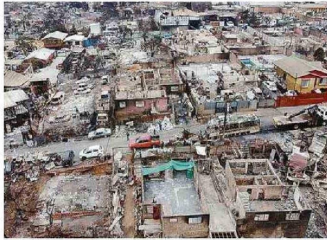
ESTE MARTES, NUEVAMENTE, NO ALCANZÓ A SER DISCUTIDO EN SALA.
