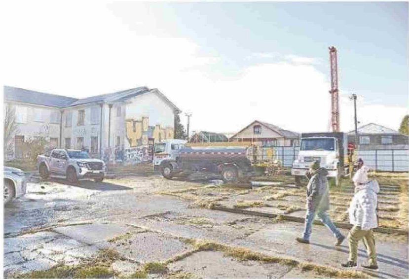
Equipos de la dirección de Vialidad trabajan en labores de estudio de suelo en los patios del viejo hospital.
