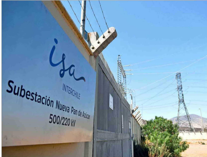
La falla del martes se produjo entre las subestaciones Nueva Maitencillo y Nueva Pan de Azúcar, uno de los tramos de la línea de Cardones-Polpaico.
