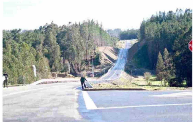
El camino inaugurado corresponde al acceso norte al balneario de Iloca, con una extensión de 11,5 kilómetros.
