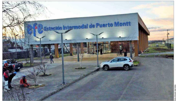
Cerca de 500 millones de pesos costó la refacción de la deteriorada estación, que ahora se llama intermodal.
