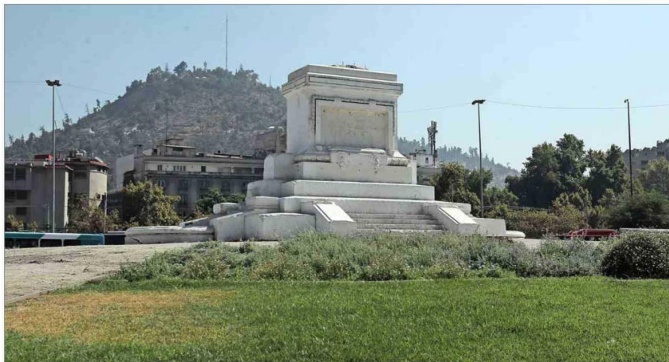
FUTURO.—El siguiente paso para el plinto será determinado por una nueva solicitud del MOP para presentar cómo será el proceso de retiro y restauración.
