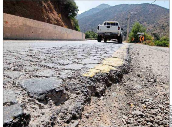
**Problemas** En la ruta hay problemas de pavimentación, daño en las barreras de contención, además de rodados de piedra, sobre todo tras las intensas lluvias y nevadas del 2024.
