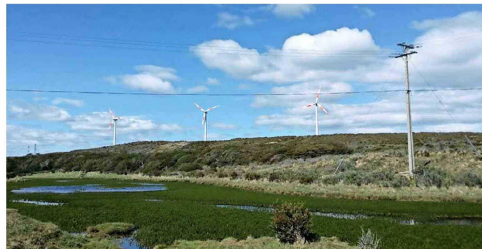
Parque eólico de Pecket Energy.
