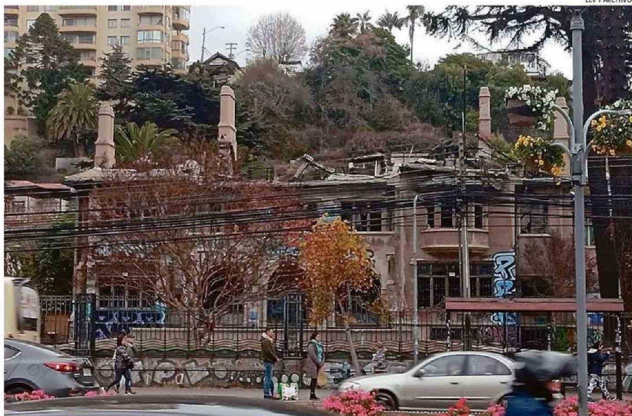
ENTRE LAS PRINCIPALES OBSERVACIONES HECHAS ESTÁ ATENDER LA FALTA DE CUBIERTA DEL INMUEBLE.
