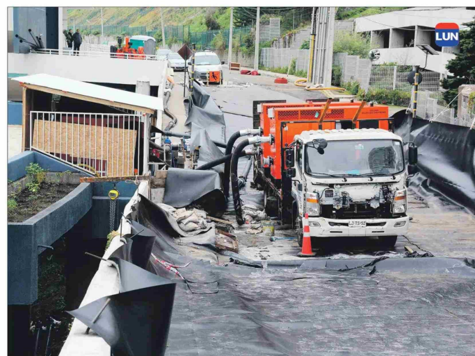
La membrana de asfalto es una capa impermeable, más rígida que la de polietileno, que se aplica sobre superficies planas para evitar que el agua se infiltre en el suelo.
