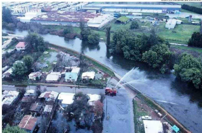
LA IMAGEN MUESTRA A UN CARRO DE BOMBEROS AYUDANDO EN EVACUAR AGUAS LLUVIAS Y SERVIDAS DE SECTOR RIBERA SUR DE LONCOCHE, EXTREMO SUR DE LA PROVINCIA DE CAUTÍN.
