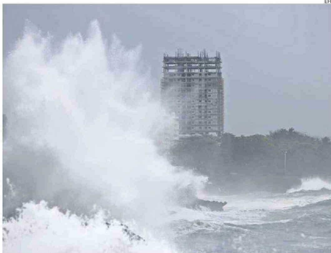
OLEAJES DESMESURADOS PROVOCARON ESTRAGOS Y SOCAVONES EN DISTINTAS LATITUDES.
