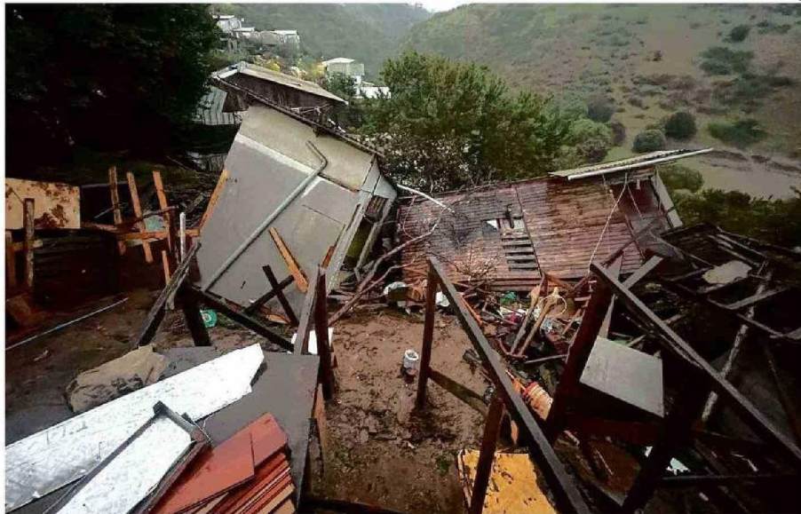
UNA CASA EN LA POBLACIÓN PUDETO DE CARTAGENA SE DERRUMBÓ CON DOS MORADORES EN SU INTERIOR
