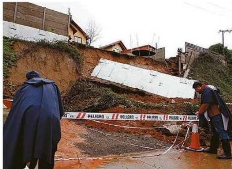
HUBO DERRUMBRES EN DISTINTOS PUNTOS DE LA CIUDAD PUERTO.
