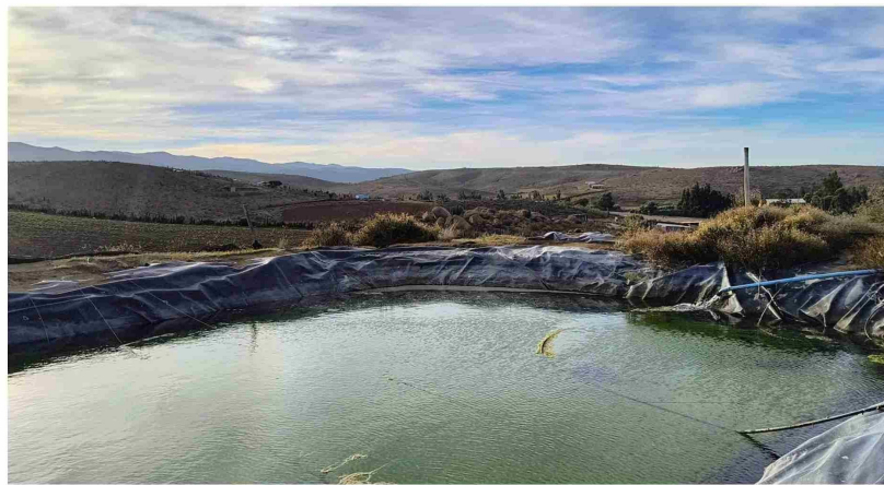
Las obras hídricas son vitales para conversar el agua, en este caso, destinada a la actividad agrícola.
