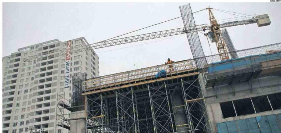
SE ESPERA QUE EN LA REGIÓN SE CONCRETEN UNA SERIE DE PROYECTOS MINEROS Y ENERGÉTICOS EN LOS PRÓXIMOS AÑOS.
