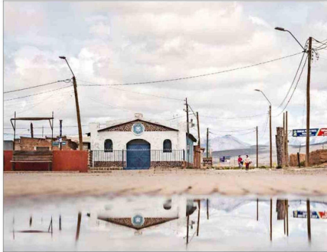
GENERAL LAGOS. — En el altiplano de Arica y Parinacota, sus 684 habitantes no cuentan con energía eléctrica y dependen de los paneles solares.
