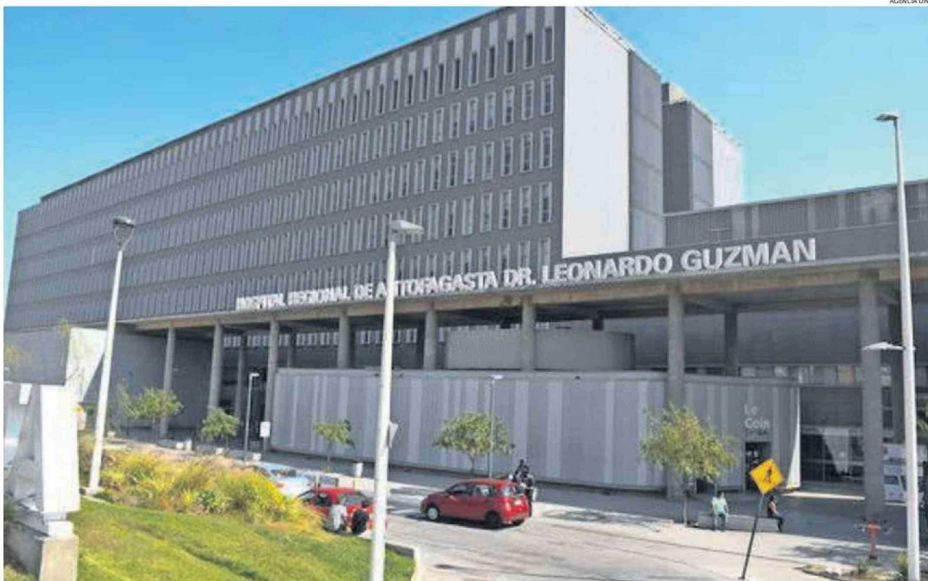
EL HOSPITAL REGIONAL DE ANTOFAGASTA HA SUFRIDO VARIOS INCIDENTES EN RELACIÓN A FILTRACIÓN DE AGUA POR EL SISTEMA DE CLIMATIZACIÓN.
