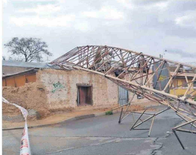
LA CASA DONDE CAYÓ LA ESTRUCTURA.
