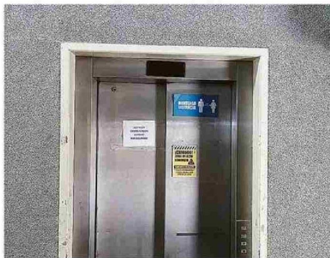
EL MUNICIPIO TRABAJA EN LA RENOVACIÓN DE LOS ASCENSORES.
