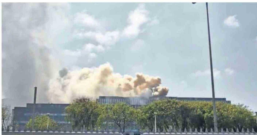
CERCA DE LAS 11 DE LA MAÑANA COMENZÓ EL INCENDIO EN EL CUARTO PISO DEL HOSPITAL REGIONAL DE ANTOFAGASTA.
