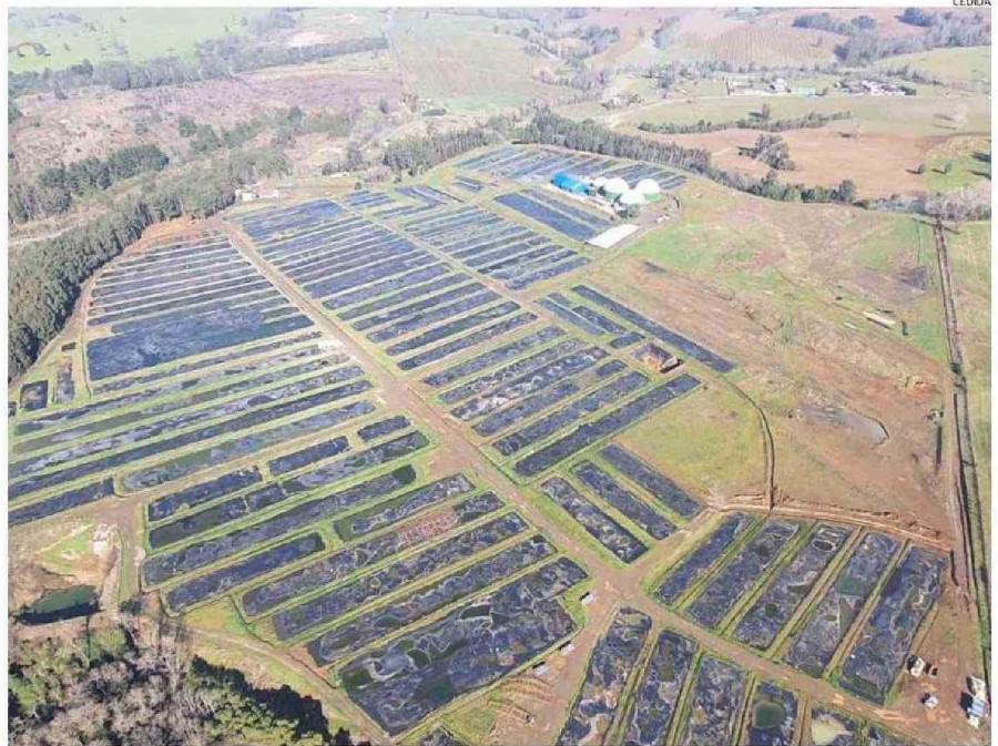
EL TERRENO DONDE ESTÁ LA PLANTA ECOPRIAL ES DE CASI 57 HECTÁREAS, DE LAS CUALES ESTÁN OPERATIVAS POCO MENOS DE LA MITAD.
