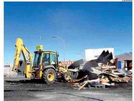
RETIRARON CERCA DE 40 TONELADAS DE MATERIAL.
